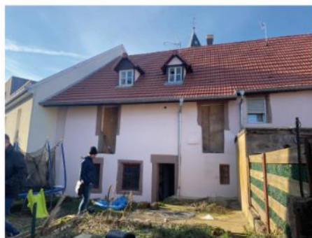
FACADE EST, sur cour privée arrière
