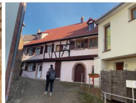
FACADE OUEST, sur cour de l'Eglise
